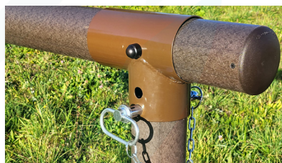
Sécurisation accès voie verte : Barrière pivotante verrouillable ouverte ou fermée
