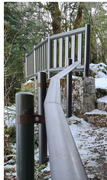
Barrière de belvédère avec main-courante
