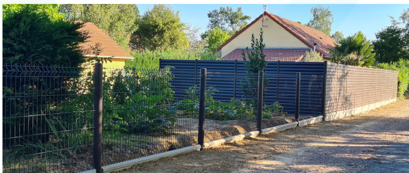
Clôture grillagée avec embase ciment
