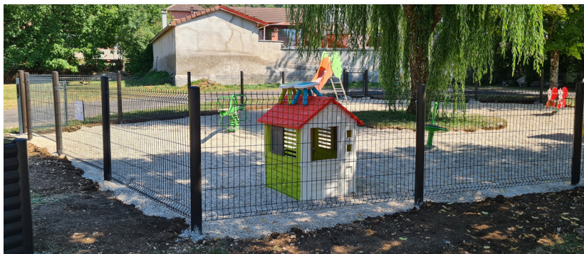
Clôture de sécurisation aire de jeux
