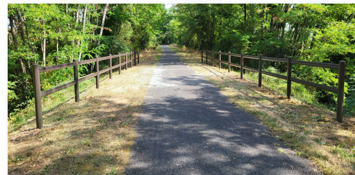
Barrière de sécurisation voie verte
