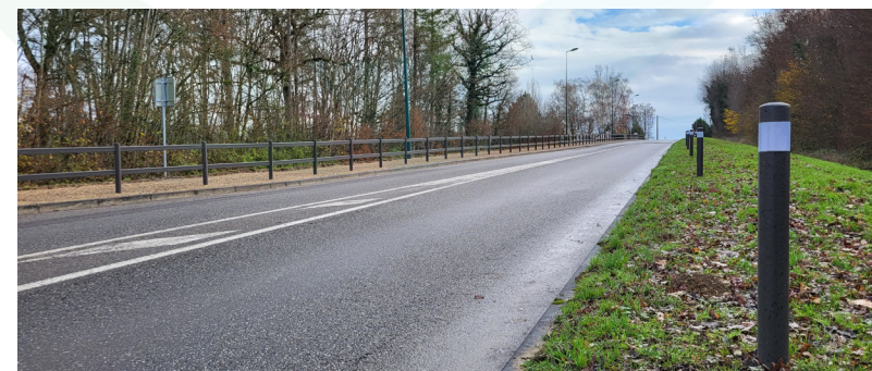
Barrière 2 lisses protection voie piétonne
