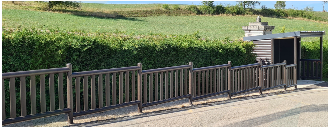
Abribus avec barrière de sécurisation
