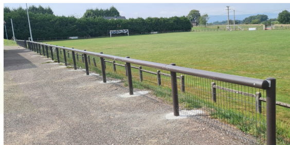
Barrière main-courante + sécurisation avec panneau grillagé
