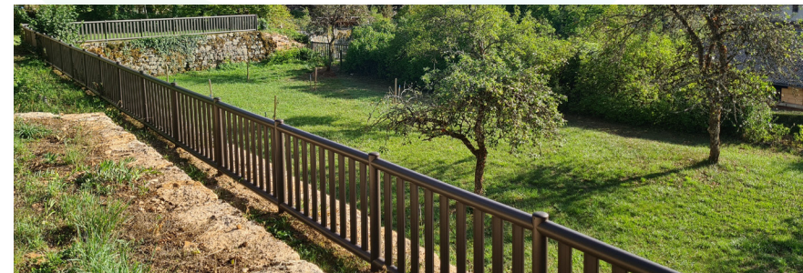
Barrière de sécurisation de belvédère
