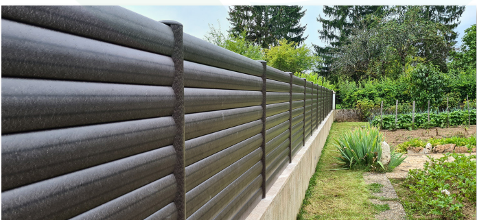
Palissade sur muret
