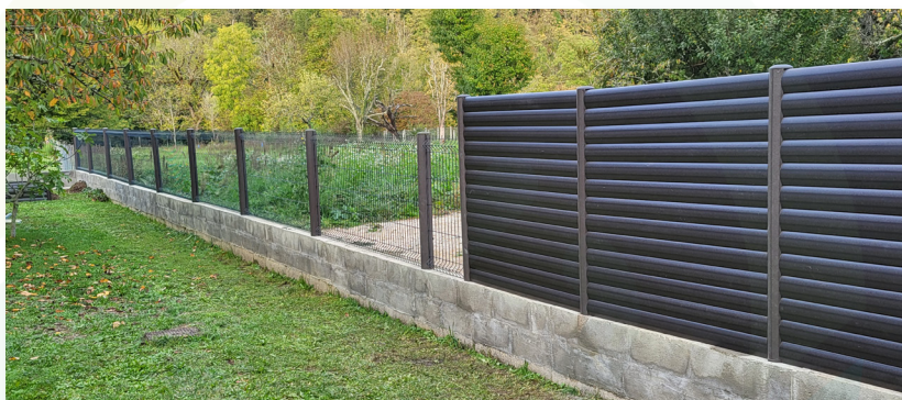
Clôture grillagée sur muret avec palissade
