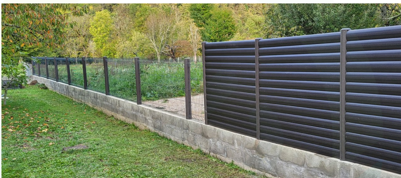
Clôture grillagée sur muret avec palissade
