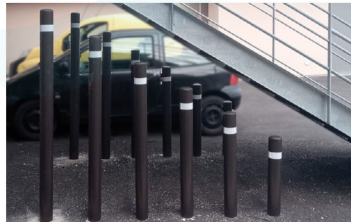
Poteaux de protection sous escalier
