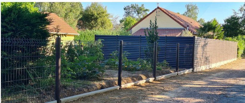
Clôture grillagée avec embase ciment
