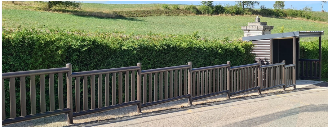
Abribus avec barrière de sécurisation
