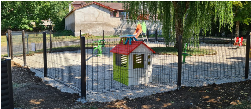
Clôture de sécurisation aire de jeux
