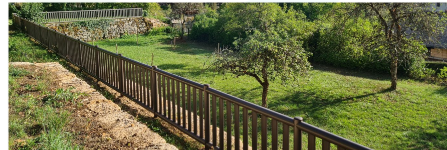
Barrière de sécurisation de belvédère
