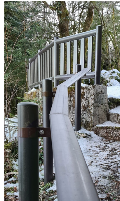
Barrière de belvédère avec main-courante
